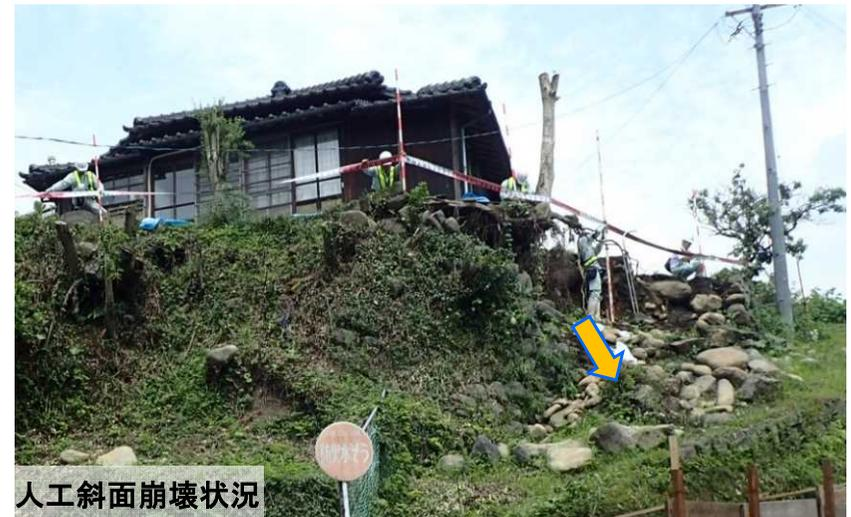
人工斜面崩壊状況
