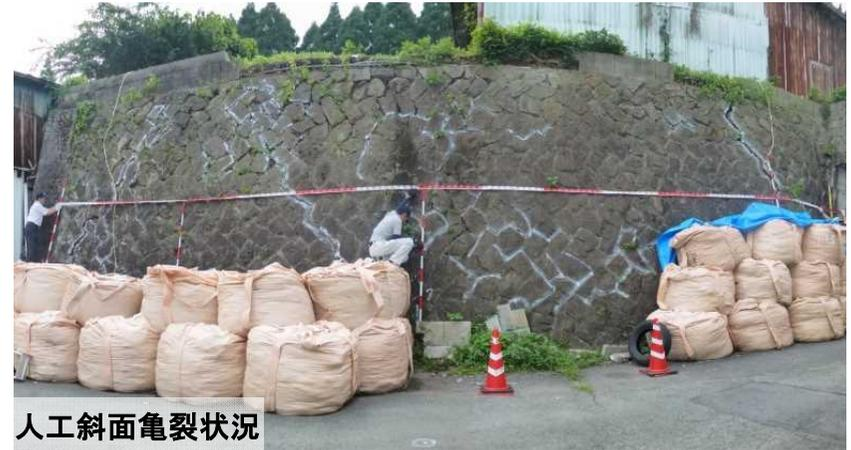
人工斜面亀裂状況
